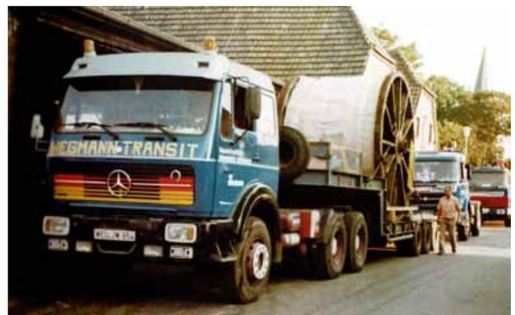
Der erste Neuwagen von Daimler-Benz wird 1977 angeschafft, ein 6x4-Dreiachser des Typs 2632. Kombiniert wird er mit einem Aufhänger von WETA-Röser. Mit seinen 10-t-Achsen wird er für Ladungen bis zu 50 t eingesetzt. Hier transportiert er eine Kabeltrommel mit Stabseilen von ARBED-Saarstahl aus Köln. Außergewöhnlich ist der Grill in Deutschland-Farben. Erstmals kommt auch die in Folge typische Beschriftung der Seitentüren mit weißen Buchstaben zum Einsatz.
